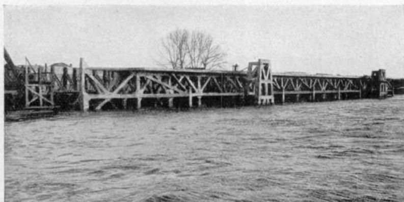
FIG. 14. — Poste d'accostage de l'Usine brûlée, à Nantes.
